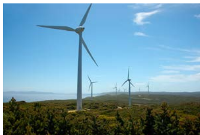
Parques eólicos - Distintos emplazamientos Australia
