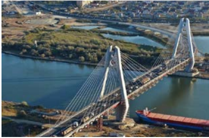
Agigea bridge - Agigea Romania
